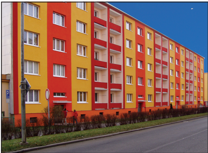
Zateplení objektu SBD, Chomutovská 1203-1206, Kadaň.
