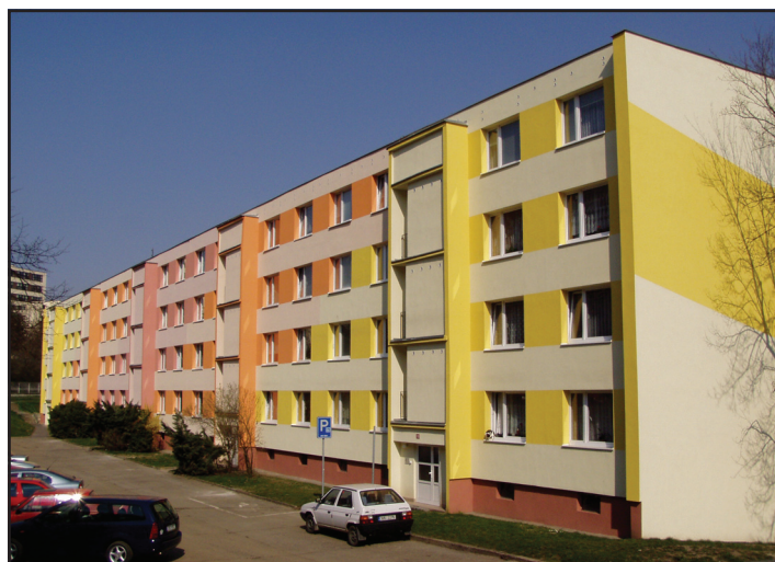
... a po opravě fasády.
