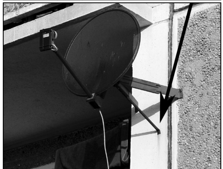
Příklad nevhodného umístění parabolické antény (viz. čl. na str. 1). Šipka ukazuje na stěkající rez.
